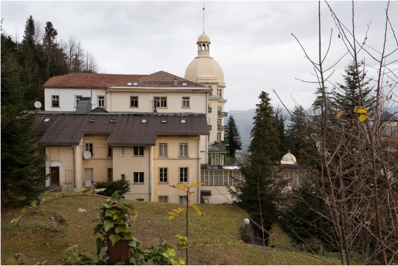
Das 1875 eröffnete Hotel Sonnenberg muss von seinem neuen Besitzer umfassend saniert werden.
